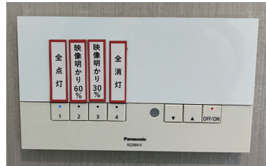
【照明操作パネル】 番号を押し照明を調光 4シーンまで記憶
